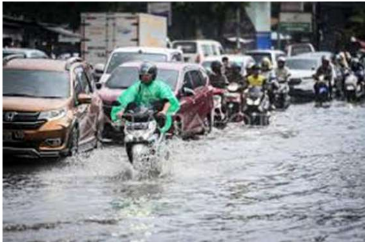
Gambar 7.1. Dampak Drainase Buruk pada Jalan (Sumber: Bina Marga, 2020)
