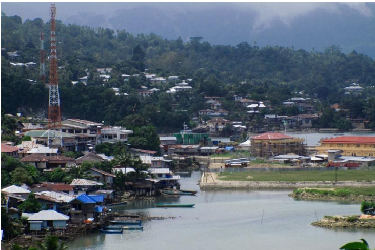
Gambar 14 Kondisi awal pembangunan kawasan reklamasi, pantai kota Fak-fak.
