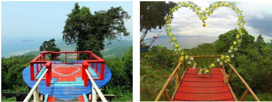
Gambar 12.1. Jembatan Cinta di Muncak Tirtayasa
