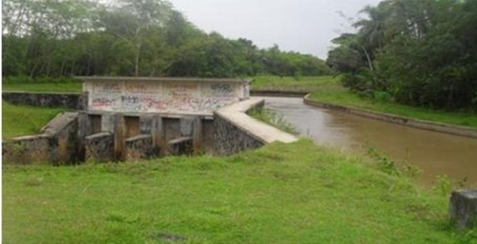
Gambar 2.9 Bangunan bagi yang terletak di saluran primer Siphon
