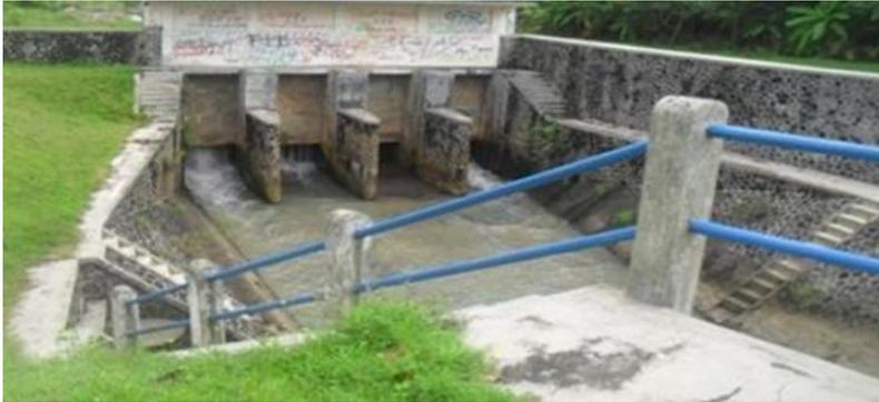
Gambar 2.7 Bangunan pembilas dengan pintu yang difungsikan untuk mengosongkan seluruh ruas saluran
