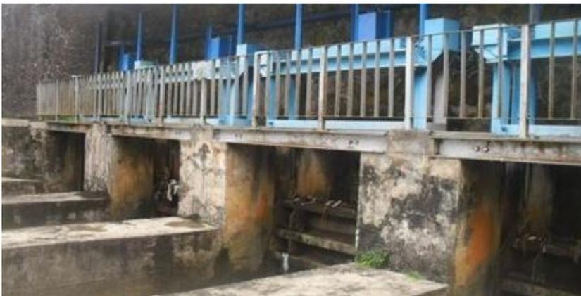
Gambar 2.6 Bangunan pengambilan yang terletak di tepi sungai yang mengalir kan air sungai ke dalam jaringan irigasi
