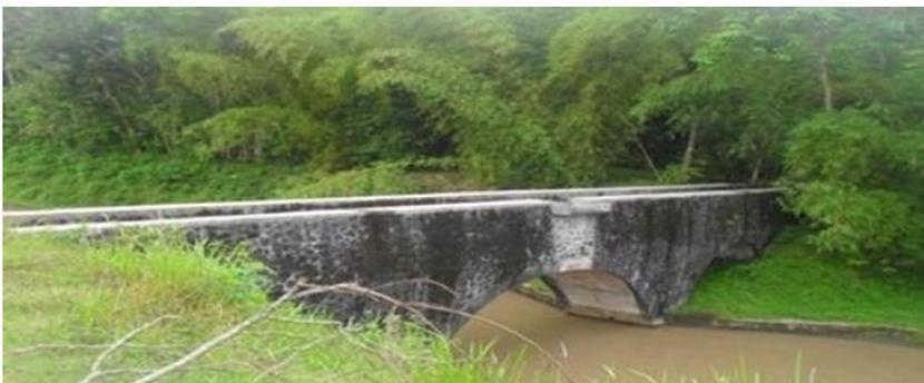
Gambar 2.8 Kantong lumpur yang dipergunakan untuk memperlambat aliran dan memberikan waktu bagi sedimen untuk mengendap
